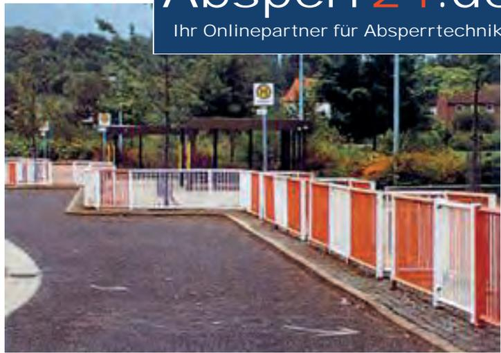
Die Befestigung der Zaunfelder an den senkrechten Pfosten ist so konstruiert, dass die unterschiedlichsten Grad- bzw. Winkelstellungen ausgeführt werden können. Bei den Querholmen der Zaunfelder zeigt immer eine Kante der Vierkantrohre nach oben, um Turnkünste zu verhindern.
